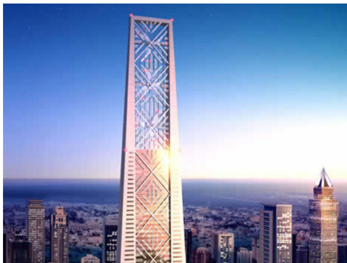
Slika 1. Kula "Lighthouse" u Dubajju, poseduje 4000 solarnih panela na južnoj strani i tri vetroturbine, čime zadovoljava sopstvene potrebe za energijom
